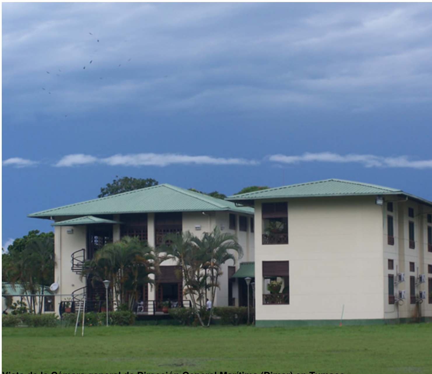
Vista de la Cámara general de Dirección General Marítima (Dimar) en Tumaco.
